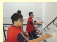
▲協同合作完成公共區域之粉刷作業
