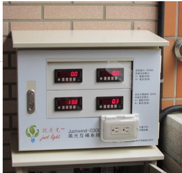
發電量即時監測系統與控制箱
